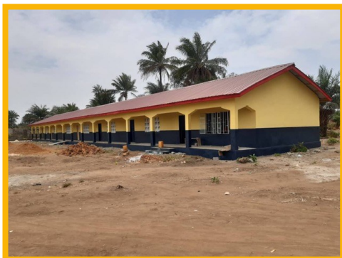
Das ist die neu erbaute Grundschule in Tintafor.
